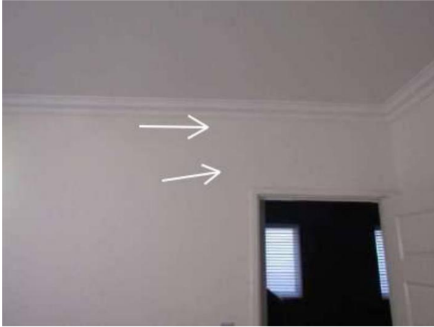
Haarrisse im Schlafzimmer über der Tür des und unter dem neu eingebauten Fenster im Obergeschoss
