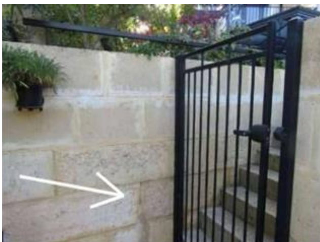
Setzungsrisse der Außenmauer und Treppe
