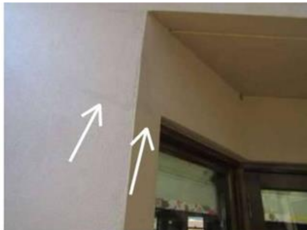
Setzungsriss der Außenmauer und der überputzten Außenmauer der überdachte Balkon
