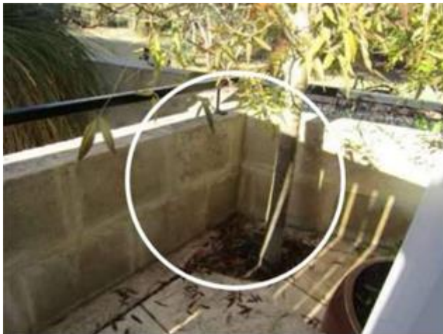
Setzungsrisse der Außenmauer
