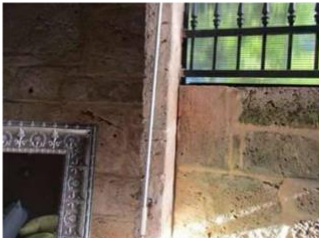
Setzungsriss der Außenmauer und der überputzten Außenmauer der überdachte Balkon
