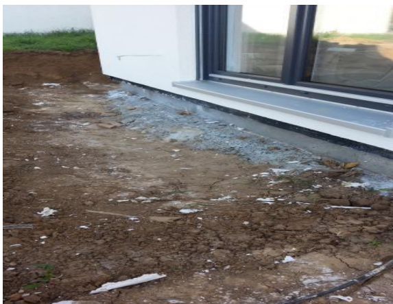
Hohlkehle auf Bitumenabdichtung
